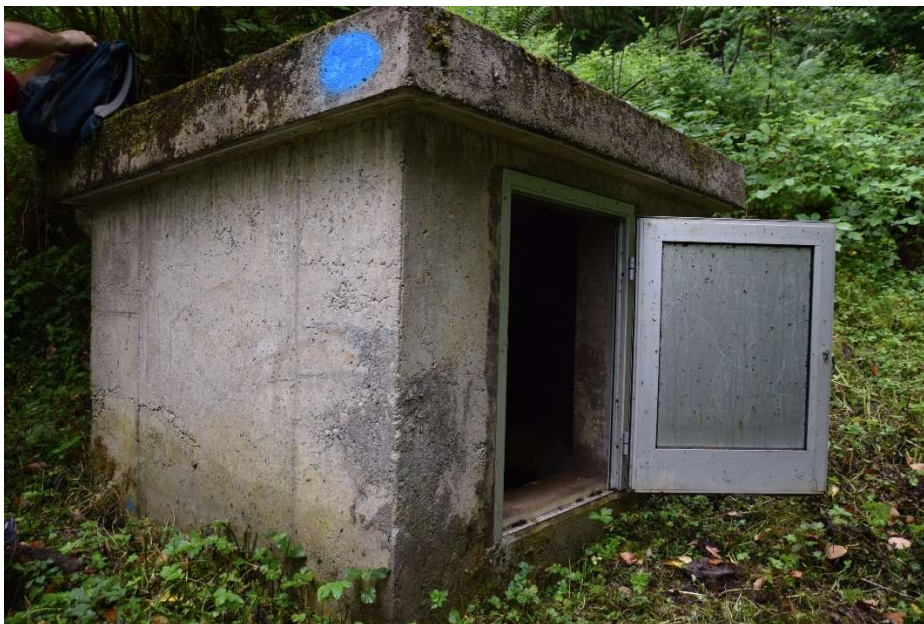
Illustration 9 : Vues d'ensemble de l'ouvrage de captage « Caou Deque les Plagnous »
